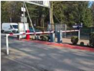
Zufahrtsschranken bei Campingplatz
