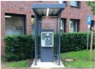
Kassenautomat mit Dach
