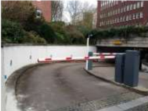
Tiefgaragen werden gerne mit einem Parksystem ausgestattet
