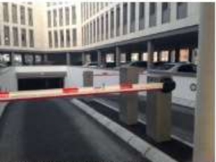
Einfahrt Parkhaus Parksystem
