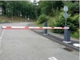
Ausfahrtsschranke und Terminal
